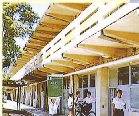
コンクリート手摺補修工事
