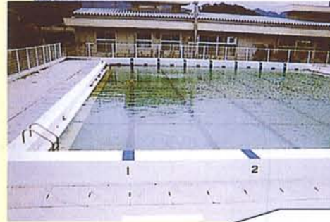
プール防水修繕工事
