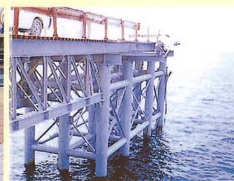
橋脚防蝕工事
