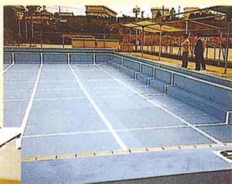
コンクリートプール防水補修工事
